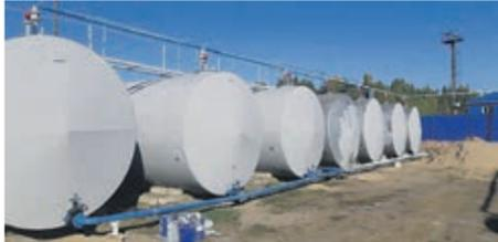
С целью соблюдения техники безопасности в Пинежском ЛПК ведется работа по покраске емкостей ГСМ. Всего необходимо покрасить 10 цистерн объемом 50 м³ каждая, которые окрашиваются в светлые тона для снижения нагревания резервуаров солнечными лучами. Большой запас топлива необходим для бесперебойной работы предприятия.
